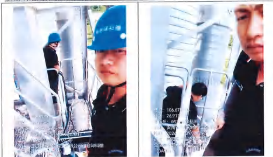
筒仓卸料棚排气筒排口 (DA013)
