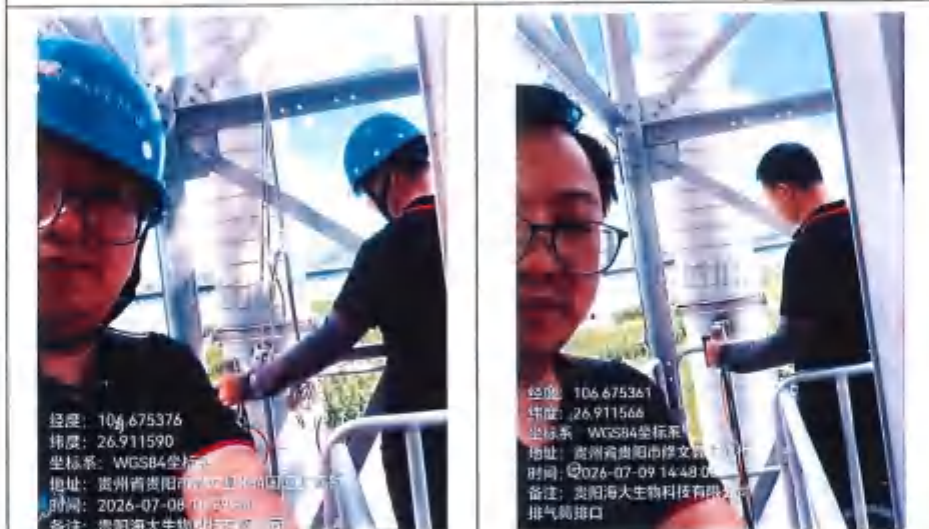
筛分排气筒排口 (DA001)
