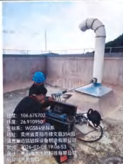
粉碎排气筒排口 (DA006)
